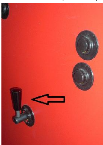
Slika 15. Položaj ručice klapne POTPALA
